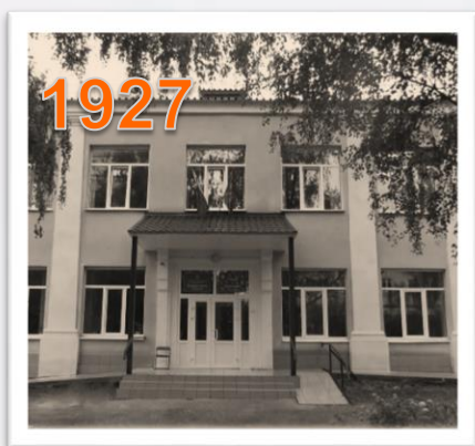
Станция юных техников
